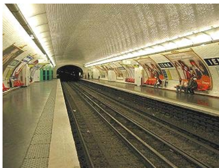
Fig. 12 Interiorul stației léna în Metroul din Paris
