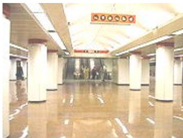
Fig. 9 Stația Kossuth Lajos pe linia 2 Metro 4
