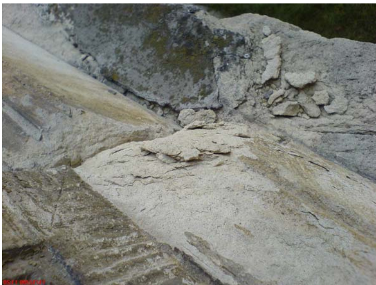
Fig. 3 Exfolierea calcarului sub acțiunea apelor meteorice acide, Muzeul de Artă, Cluj (Palatul Banffy)
