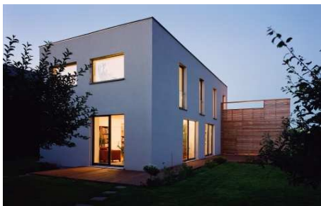
Fig. 4 Casa pasivă Abendroth – Gerasdorf
