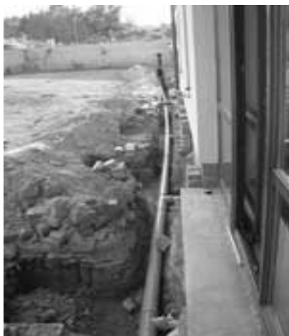
Fig. 3 Depresurizare Radonului de sub fundații
