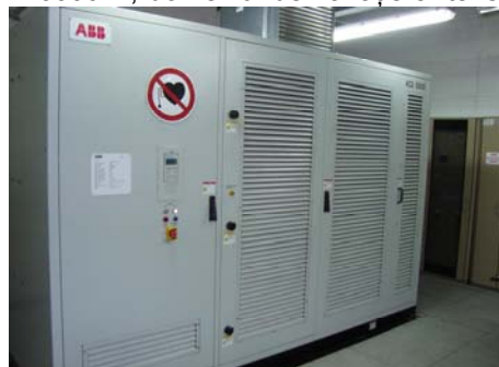
Fig. 8 Duplul convertizorului de tip ACS 5000 – 2100 kVA
