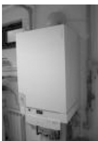
Fig. 1 Centrala termică de perete Phanter 24,6 kW
