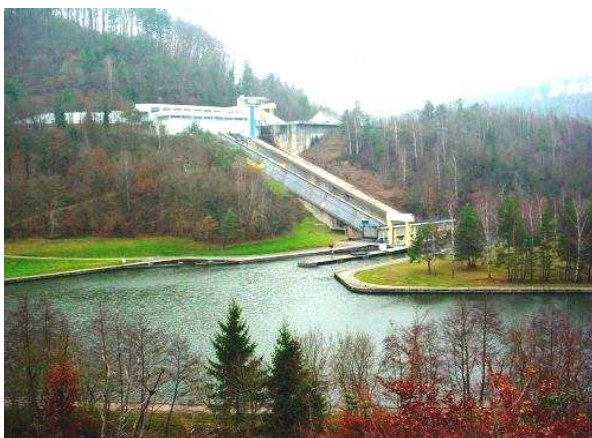
Fig. 2 Vedere de ansamblu a planului înclinat Saint-Louis-Arzviller
