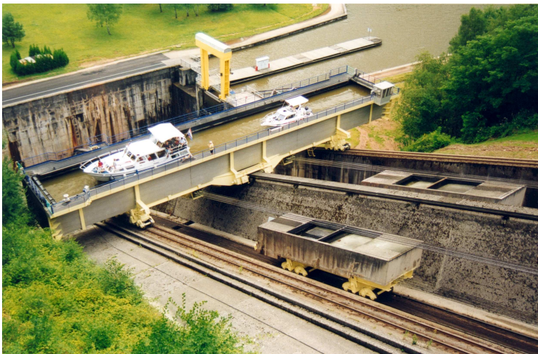
Fig. 5 Vedere de ansamblu a Planului înclinat Saint-Louis-Arzviller.
