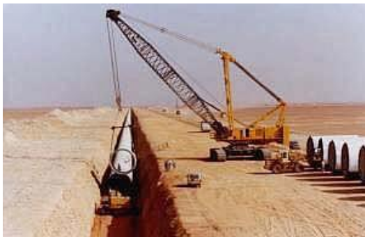
Fig. 4 Construcția șanțurilor uriașe și pozarea conductelor de 4 m diametru
