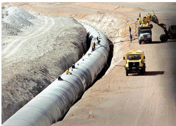
Fig. 6 Ultimele verificări și ajustări înaintea acoperirii conduței
