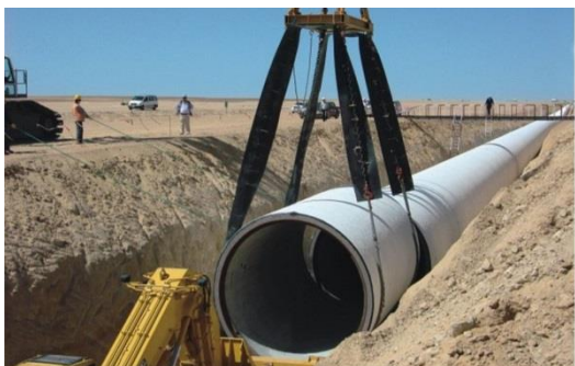
Fig. 4 Construcția șanțurilor uriașe și pozarea conductelor de 4 m diametru
