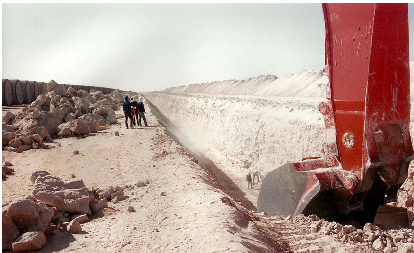
Fig. 5 Construcția/săparea imenselor șanțuri, cu utilaje pe măsură
