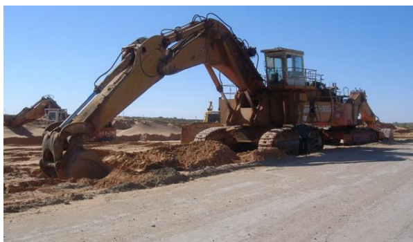
Fig. 7 Utilaje uriașe "mușcă" din nisipul Saharei, pregătind locul și traseul conduțelor
