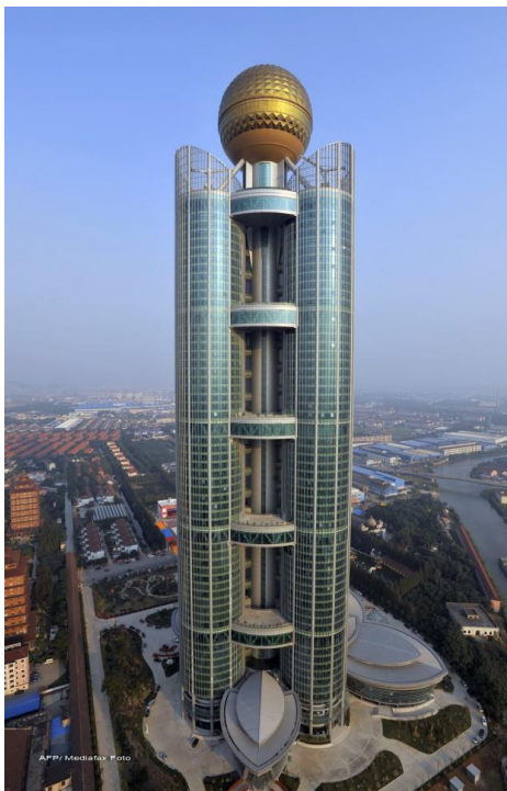
Fig. 3 Zgârie nori cu 74 de etaje, a 15-a cea mai înaltă construcție din lume. Depășește la dimensiuni Turnul Eiffel din Paris și Turnul Chrysler din New York. Acest turn uriaș care a fost construit în Huaxi, cel mai bogat sat din China, care are înregistrați oficial doar 2.000 de rezidenți, toți fermieri, a costat 350 de milioane de euro
