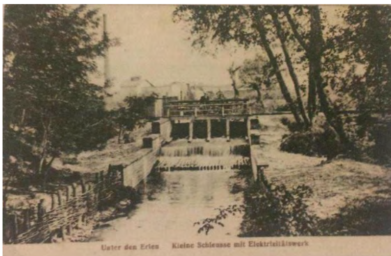
Fig. 12 Canalul uzinei electrice - Ilustrată circulată aprilie 1914
