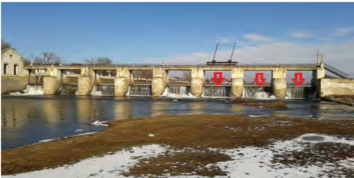
Fig. 7 Vederea din aval a barajului MCHE Căză- nești de pe râul Răutu
