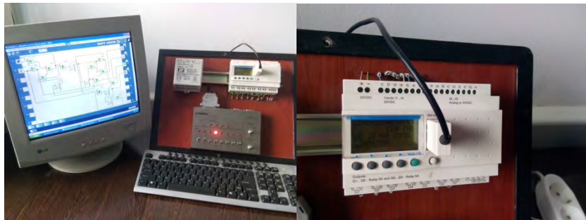
Fig. 10 Standul de laborator cu AP Zelio Schneider Electric și modulul de simulare Schenck în momentul de testare a stării de avarie și AP cu rularea oprită
