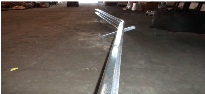
Fig. 7 Parapet deformat. Vedere de ansamblu
