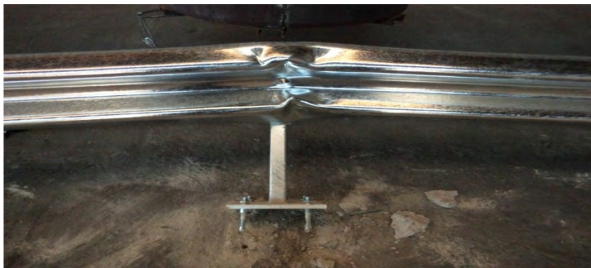
Fig. 4 Stâlp testat. Vedere din față
