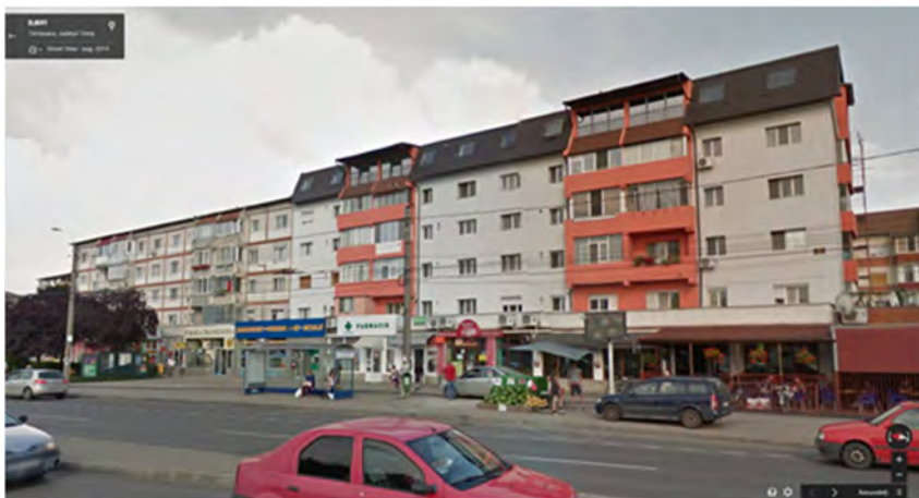
Fig.1 Bloc reabilitat prin programul privat de mansardare în Calea Sever Bocu din Timișoara (imagine preluată maps.google.ro - Google Streetviewer)
