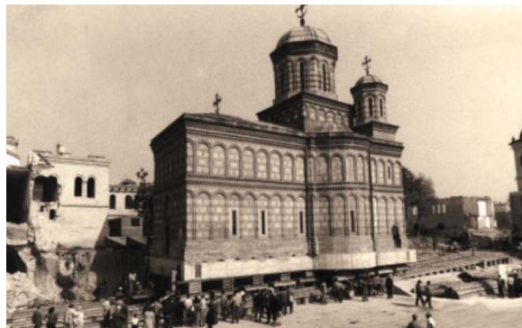
Fig. 2 Biserica Mihail Vodă, București (monument istoric din sec. al XVI-lea): biserica: 3.100 t, clopotnița: 289 t, a fost mutată în 1985 pe o distanță de 289 m, cu tot cu turnul clopotniței
