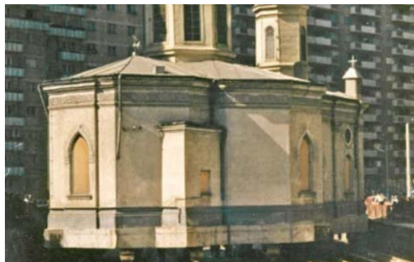
Fig. 3 Biserica Capra a fost salvată de la demolare în anul 1986, fiind în prezent amplasată la câțiva metri de locul inițial, pe terenul cimitirului parohial din spatele acesteia
