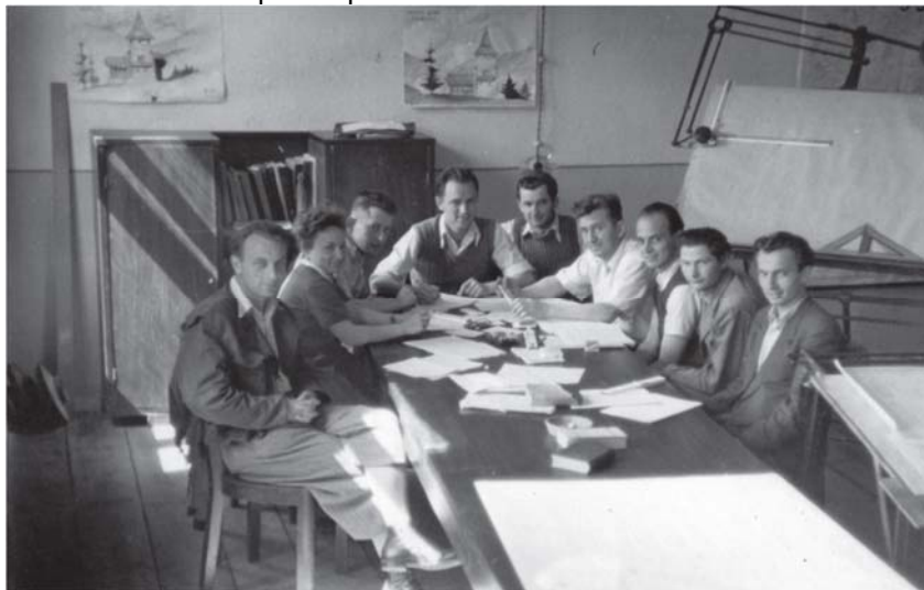
Colaboratori la amenajarea hidrocentralei Bârzava și Reșița, 1947 Pavel, D., Arhitectura apelor , ediția a 2-a, Editura MEGA, Cluj Napoca, 2015, pag. 299
