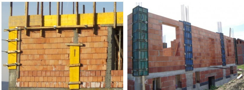
Fig.5 Cofrare cu elemente din lemn sau metalice
