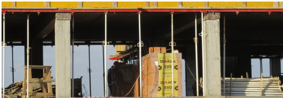
Fig.4 Materiale depozitate pe zona de începere a lucrărilor
