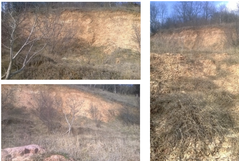
Fig.1 Amplasamentul studiat – zona afectată de alunecări de teren
