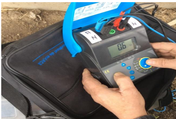
Fig. 4 Valoare măsurată, înregistrată și arhivată a prizei de pământ
