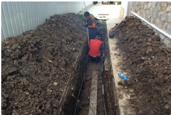
Fig.1 Execuția prizei de pământ cu electrozi orizontali și verticali
