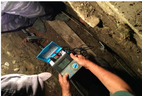
Fig. 2 Efectuarea măsurătorilor pentru rezistența de dispersie a prizei de pământ cu aparatul de măsură omologat și verificat metrologic
