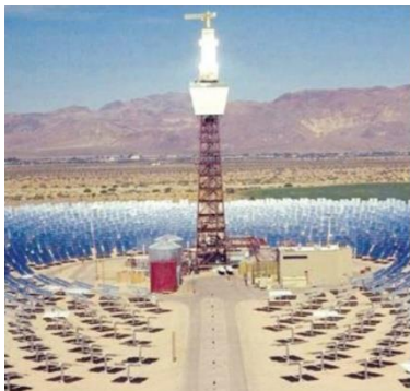
Fig. 7 Instalație solară din Israel
