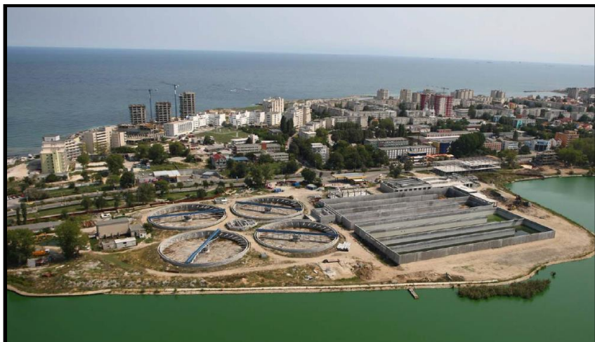
Fig. 3 SEAU Constanța Nord. Vedere de ansamblu
