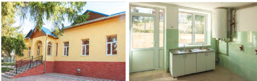
Fig. 5 Grădinița din satul Vînători după reabilitare
