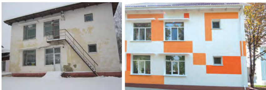
Fig. 3 Grădinița „Andrieș” din orașul Ungheni înainte și după reabilitare
