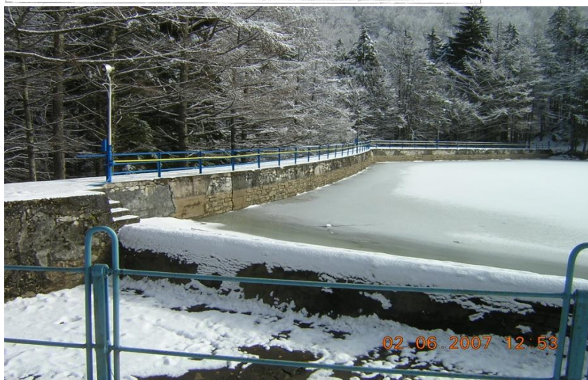
Fig. 5 Barajul Văliug, vedere amonte, în anul 2007
